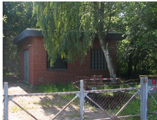
Pumpwerk in der Feldmark
